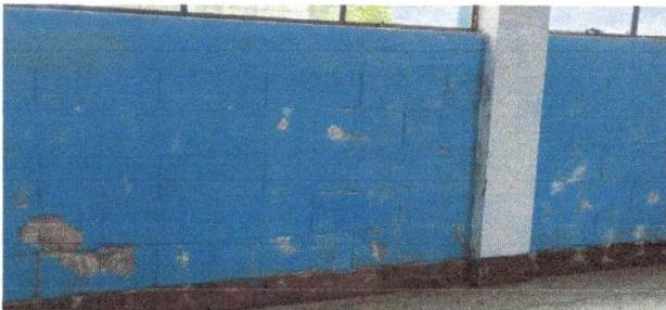
Foto 5: Pintura en muro exterior
