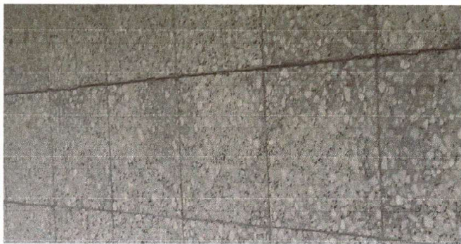
Foto 3: Sustitución de piso de granito
