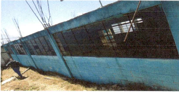
Foto 1: Sustitución de estructura de metal de ventanas
