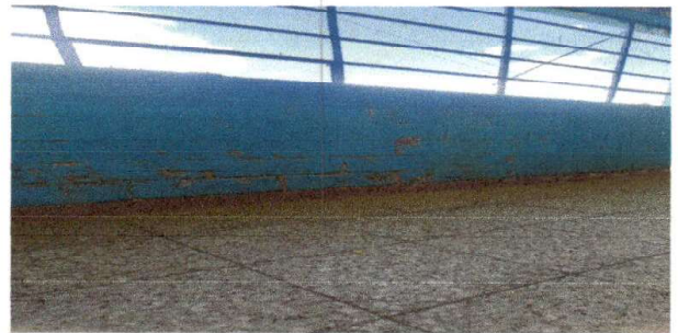
Foto 4: Pintura en muro interior
