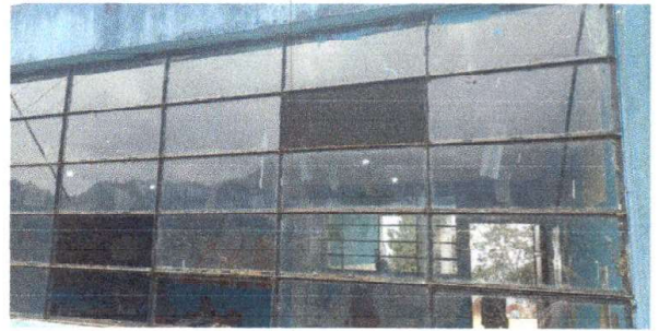
Foto 2: sustitución de vidrios
