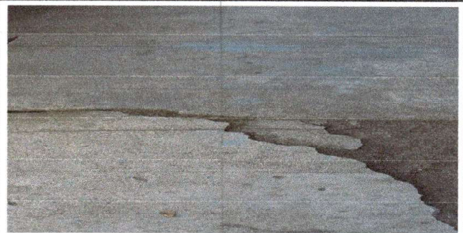
Foto 6: Reparacion de plancha de concreto de patio
